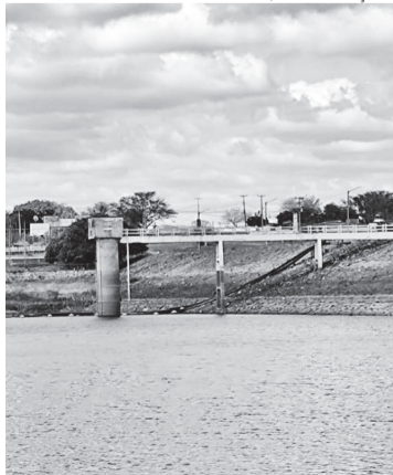
Reservatórios têm 1,92 bilhão de m³
